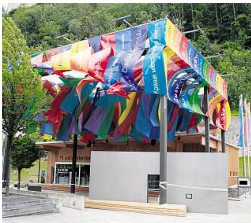
Leicht beschädigt: Durch den starken Wind haben sich beim Expo-Pavillon die Metallstangen aus dem Saum der Fahnen herausgelöst. Bild Daniel Ospelt
